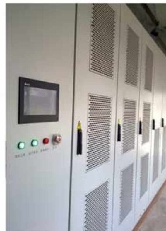
• MVD1000 для циркуляционного насоса
